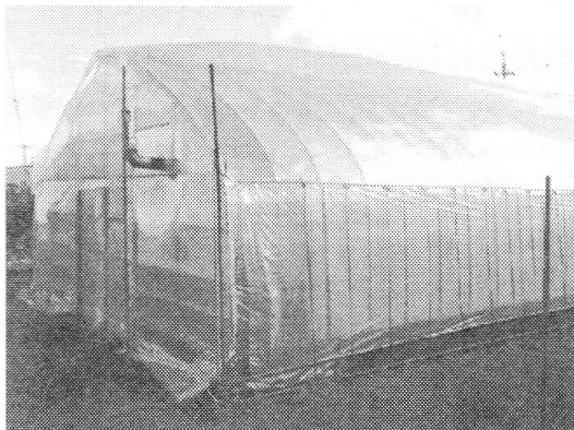
図2 外張り空気膜ハウスの外観
