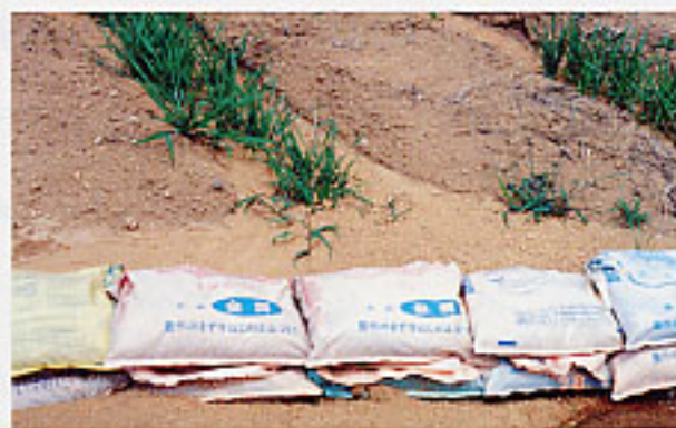
写真2 土壌による土止め
