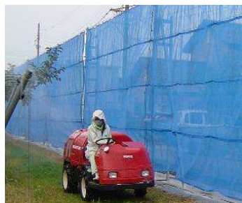
ネットの設置
