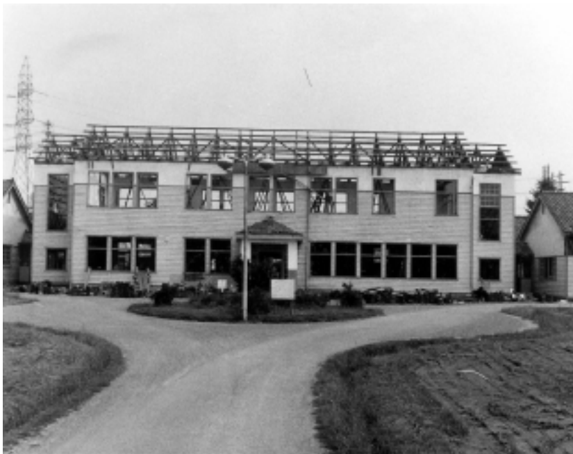
解体中の本館(昭和43年)
